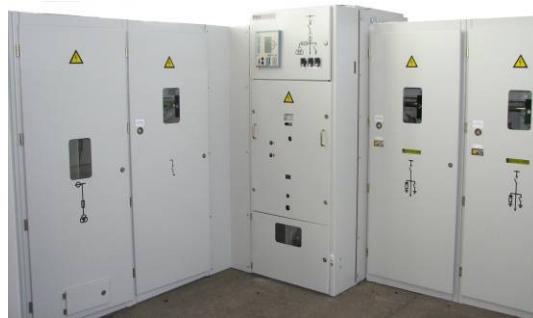
Slika 6. Konfiguracija srednje naponskih ćelija i ugaoni spoj zbog ograničenog prostora stanice
